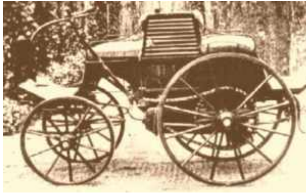
Primer vehículo construido por la primera empresa de automóviles, Panhard-Levassor equipado con un motor de gasolina.
