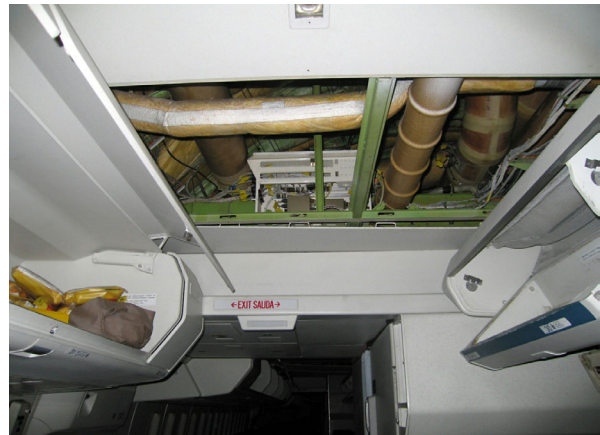
Figura 4. Techo de cabina de pasajeros
